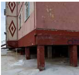
Вместо фундамента – сваи на вечной мерзлоте
