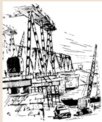
Строительство моста через реку Абакан, рис. 1960 г.
