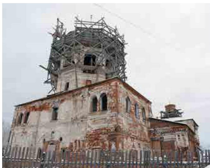
Долгое время в здании Богоявленского собора размещалась угольная котельная
